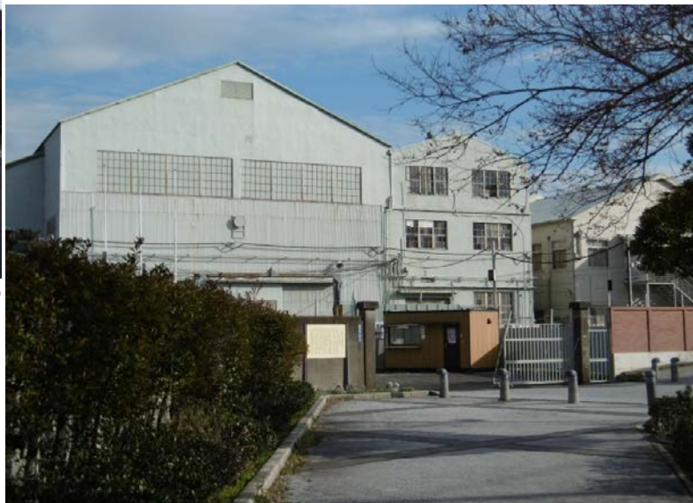
旧浦賀ドック正面入口
