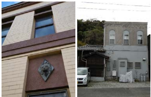
浦賀のまち中に残る洋風建築
