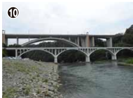
⑩ 新旧小倉橋／ 相模川に架かる道路橋です。美しいアーチ型の橋は、城山のシンボルであり、「かながわの景勝50選」、「神奈川の橋100選」、「相模川八景」にも選ばれており、さらに「推奨土木遺産」にも認定されています。
