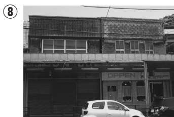
⑧ 同じ間口ながら銅板の葺き方、窓のプロポーションで変化をつけている建物 建造：昭和初期
