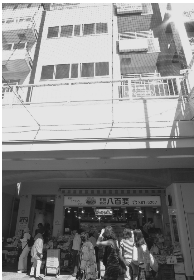
3号棟八百屋と吹抜けを通して見た上部
