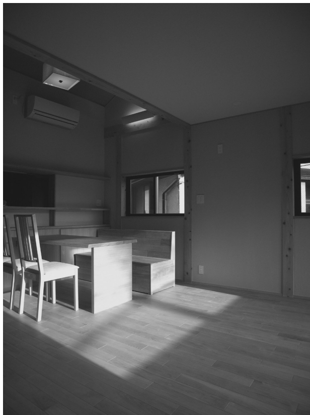
2階LD//壁は真壁で柱表し、壁はシラス壁
