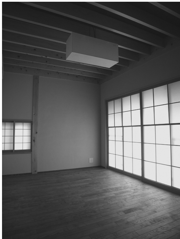
1階板の間//天井仕上げは根太表し、 床の構造用合板も県産檜で合板造り表し
