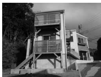
県条例による崖崩落防止壁
