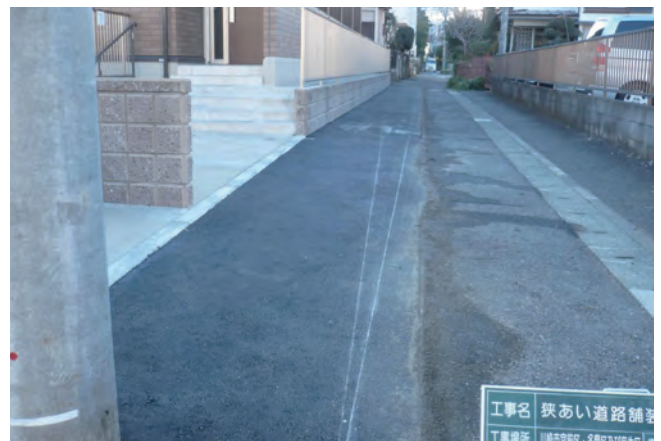
●舗装完了の様子
