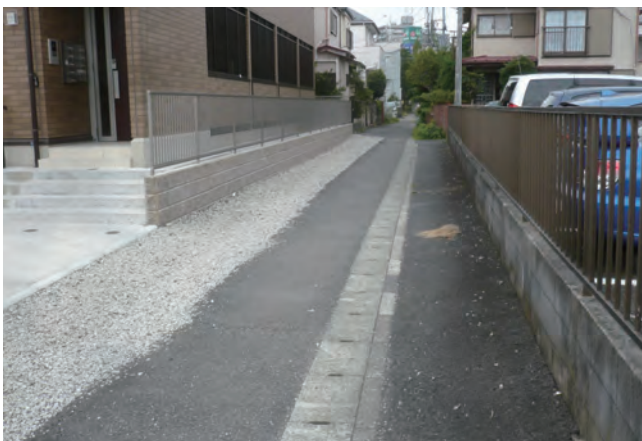
●舗装前の様子
