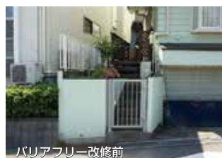
バリアフリー改修前
