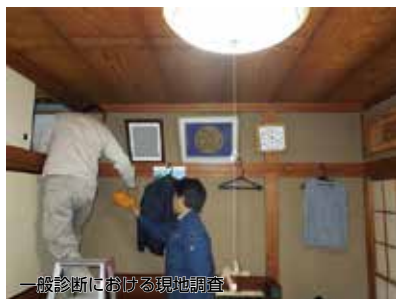
一般診断における現地調査
