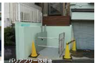
バリアフリー改修後
