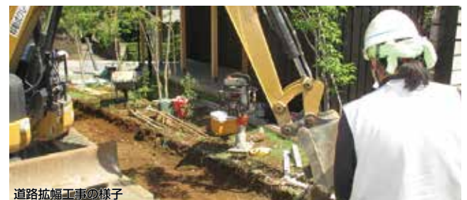
道路拡幅工事の様子
