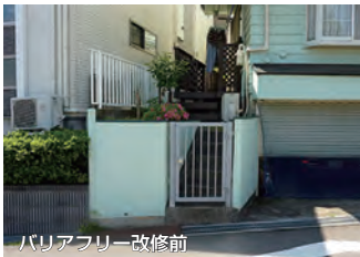
バリアフリー改修前
